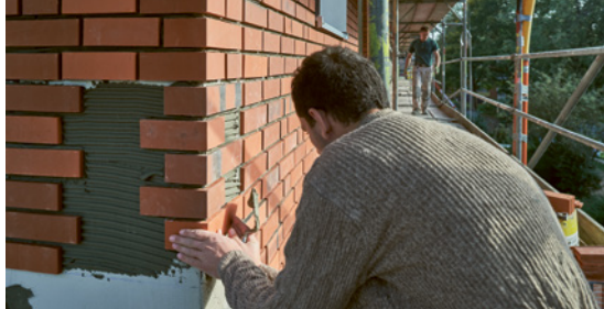
Die energetische Modernisierung des ersten Bauabschnitts in Langenhorn ist nahezu abgeschlossen. Der nächste Bauabschnitt erfolgt 2018.
