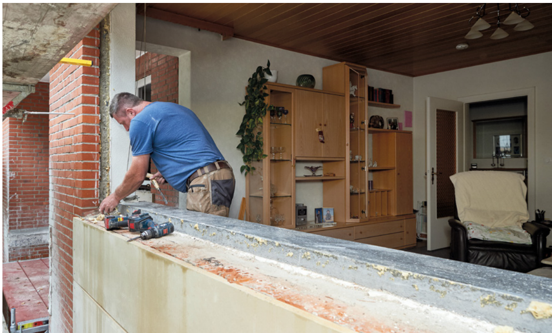
Energetische Modernisierung in der Hans-Schwenkel-Wohnanlage in Langenhorn. Hier erfolgt gerade der Fensteraustausch.
