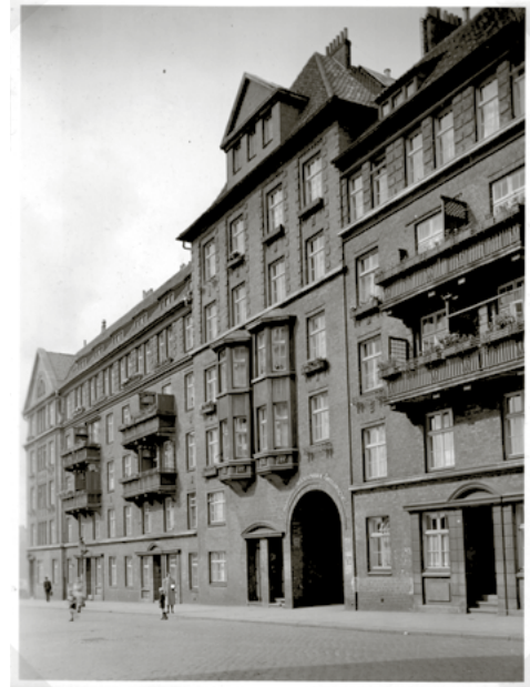
Die gegenüberliegende Fassade Martin-Luther-Straße mit Durchgangsportal zur Winklerstraße vor 1943
